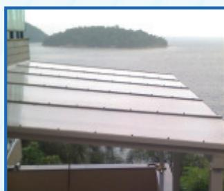
Material translúcido e leve para ambientes com iluminação natural. As chapas de policarbonato alveolar MULTILUX<sup>®</sup> da Replaex são largamente utilizadas em projetos onde se quer o aproveitamento da luz natural. Com a estrutura alveolar, que proporciona isolamento térmico, podem ser feitas coberturas ou fechamentos verticais.
