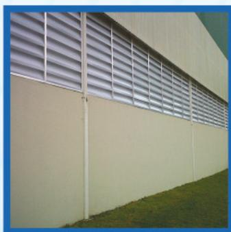
As aletas de venezianas em policarbonato representam um sistema econômico para proporcionar ventilação constante, combinada com iluminação natural em aplicações de fechamentos verticais.
