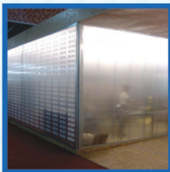
Aplicação de divisória interna
