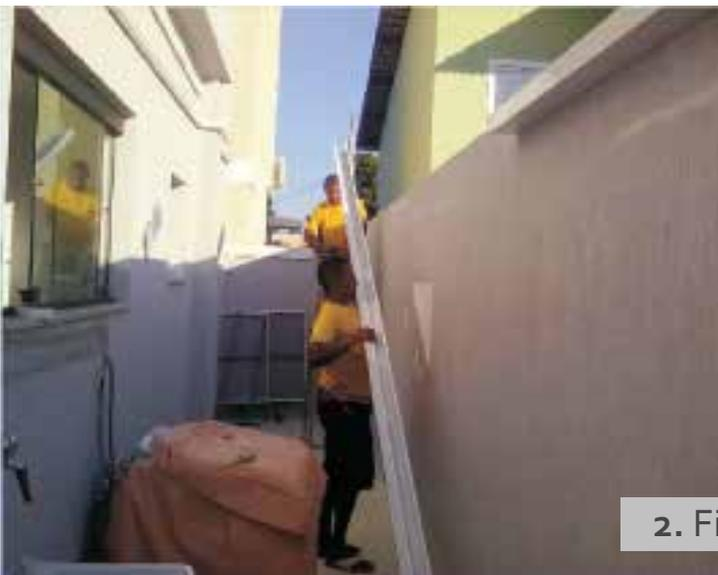
2. Fixação do Perfil Viga Calha em alumínio
