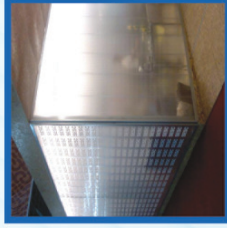
Aplicação de divisória interna
